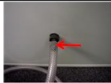
ストレートを差込み
