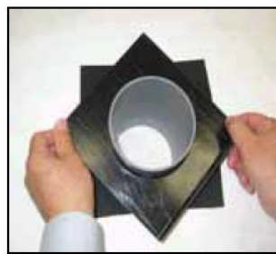
パイプ受けを治具として押し込む
