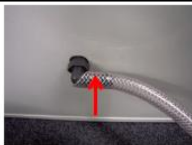
エルボを差込み
